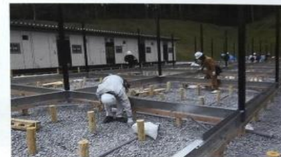
⑥ 気仙沼市内で建設が進む仮設住宅 (2011年5月)
